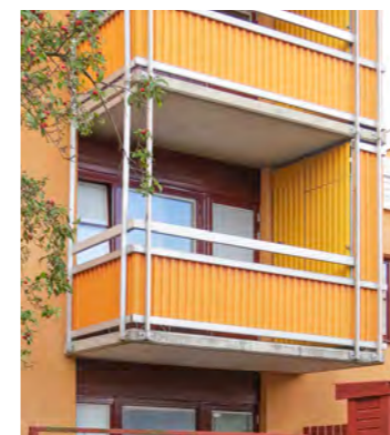
Balkongfront och räcke i plåt, 1970-tal.
