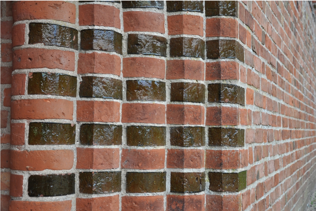
Figur 9:5. Lögumkloster Klosterkirke, södra Jylland, kyrka från 1200-talet. Höga fönster under gotiska valvbågar inramas av formtegel, vartannat skift har utförts med glaserat tegel.
