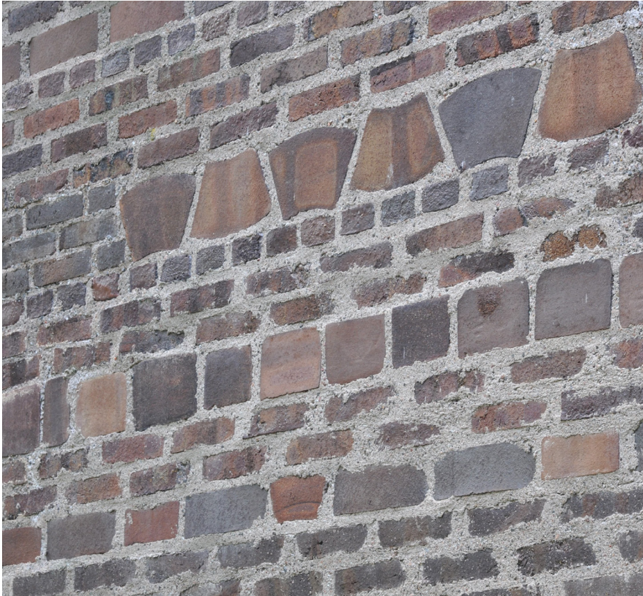
Figur 9:2. Markuskyrkan, Björkhagen, 1961, arkitekt Sigurd Lewerentz. Hårdbränt tegel, utdraget fogbruk. Bilden visar en del av en fasad där olika, udda tegelformat murats in.
