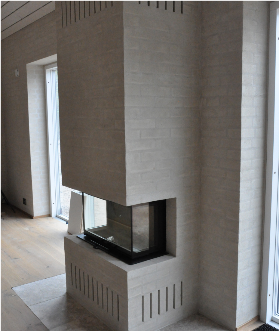
Figur 9:1. Bostadshus, Ranarp, 2022, jais landén arkitekter, murare Murar'n, Mellbystrand. Kanal-mur ½-sten tegel med invändig säckskurning. Öppen spis integrerad med bakmuren, stenplattor i golv inpassade i trägolv utan list.
