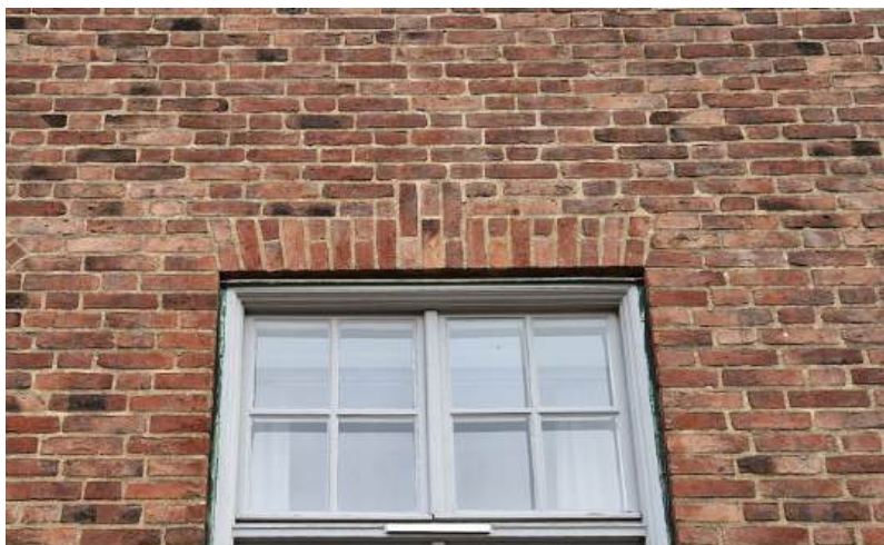
Figur 2:6. Bild av fönsteröppning med slaget valv
