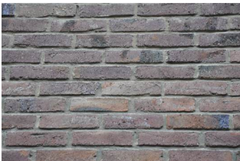
Figur 2:3. I denna fasad finns inte några koppstenar. Trots stor variation i form och kulör utgörs fasaden i detta fall av en skalmur.
