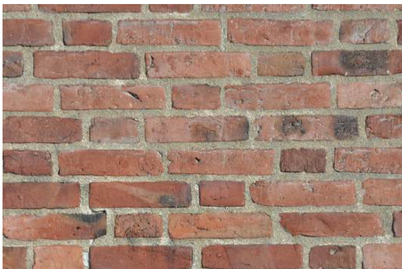
Figur 2:2. Regelbundet förband med koppstenar (i detta fall munkförband) samt stor variation i form och kulör indikerar fullmurad konstruktion.
