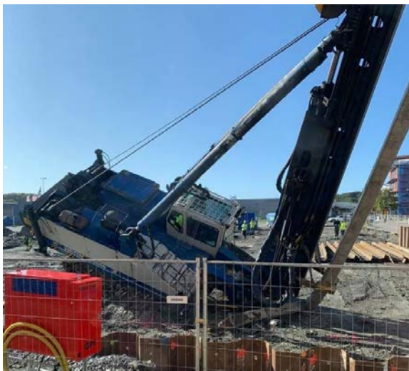
Figur 2:5 (Ovan t.v.) Bärighetsbrott under larv, eventuellt på grund av att man tidigare utfört en provgrop i detta läge som inte återfyllts och packats korrekt. Hög tyngdpunkt av påle och hejare.
