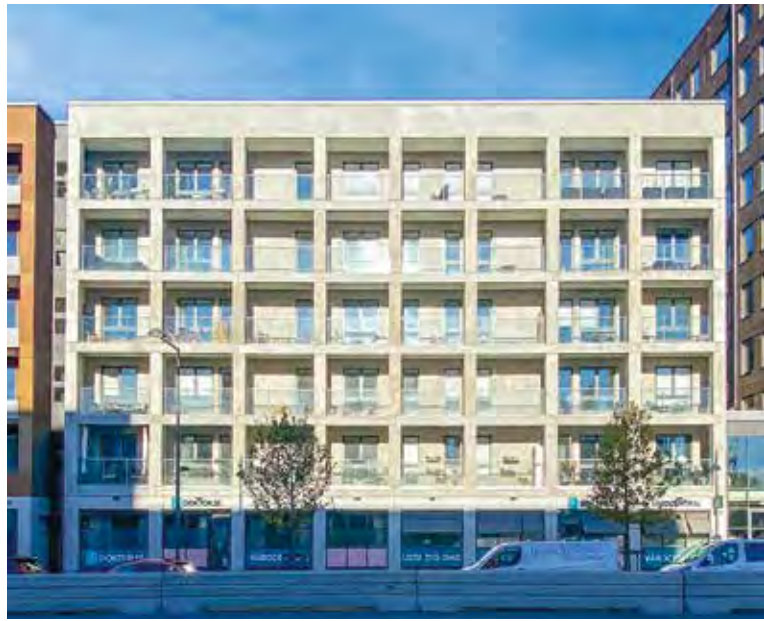
Ramverk i fasaden bildar geometriskt mönster, Stockholm.
