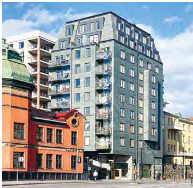
Takkupor i ovan taklisten avsmalnande byggnad, Stockholm.
