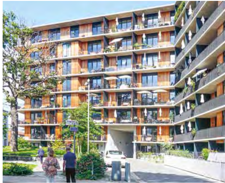
Balkonger täcker hela fasadens insida mot platsbildning, Stockholm.
