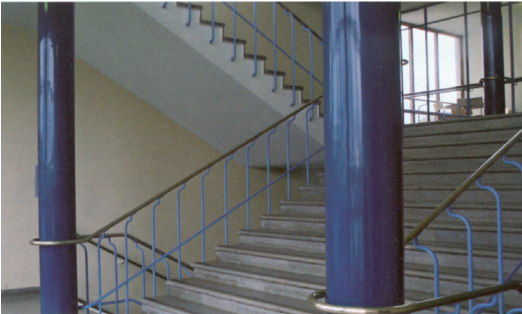
Norra flickläroverket, Sveaplan, Stockholm. Arkitekter Nils Ahrbom och Helge Zimdal 1936. Restaurerat 1996 med intentionen att återskapa ursprungsfärgsättningen.
