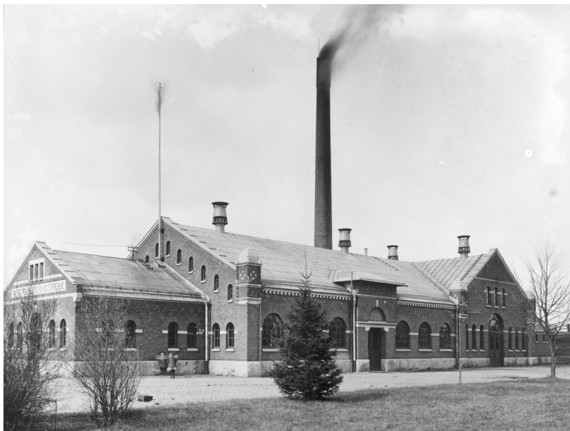
Vattenspumparna drevs med koleldade ångmaskiner. Helsans vattenverk, Gävle, ca 1900. Gävle kommuns bildarkiv.
