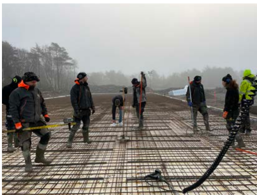
Bild 3:1. Tidigt på morgonen står alla gjutare och väntar på betong till den 2000 m 2 stora betongplattan.
