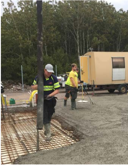
Bild 3:3. Utläggning med hängande slang.
