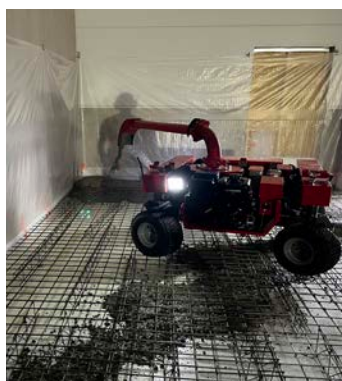
Bild 3:11. Utläggning med linedragon.
