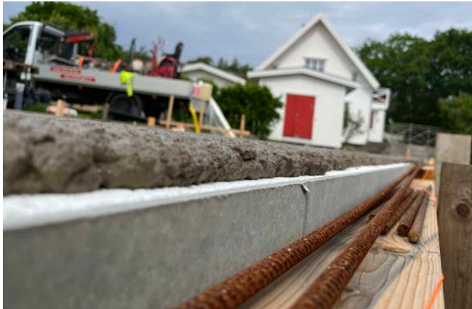
Bild 3:2. Formens övre kant varierar och betongåtgången ökas men fördehlen blir att ett plant golv kan gjutas och glättas utan att i efterhand behöva slipa ner formkanter.
