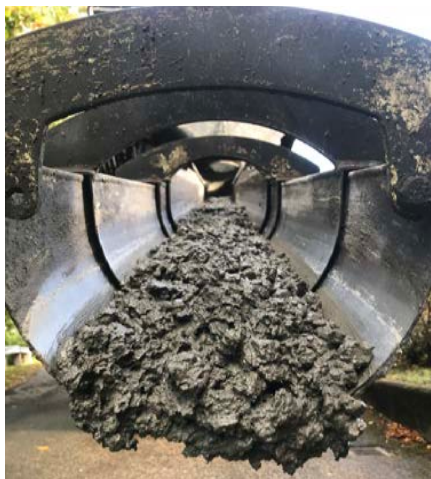
Bild 3:7. En styrbar ränna som är monterad bakom betongbilen där betongen transporteras framåt av gravitationen.
