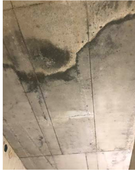
Bild 3:4. Underkant av valv där gjutskarven inte har arbetats ihop tillräckligt.
