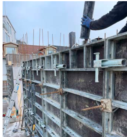
Bild 3:6. Gjutning med fri fallhöjd bör undvikas.
