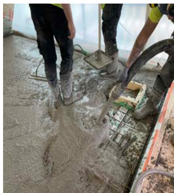
Bild 3:9. Utläggning med liggande slang.
