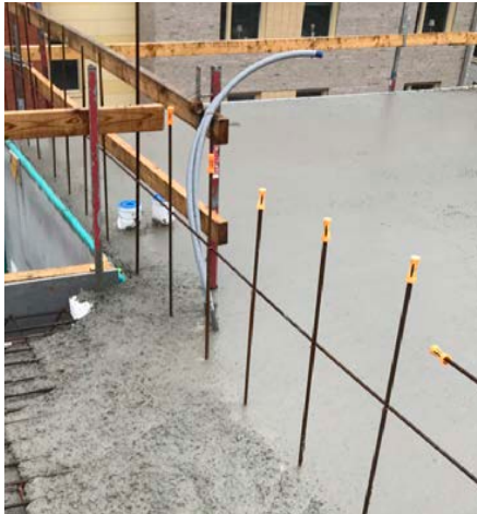
Bild 3:5. Betong har lagts förbi uppstickern och kunnat slodas med ett jämt resultat.
